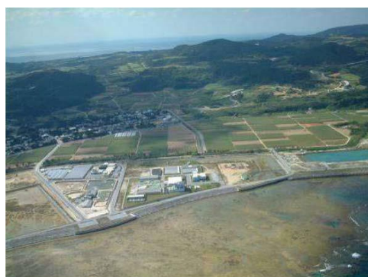
図4 沖縄県海洋深層水研究所
