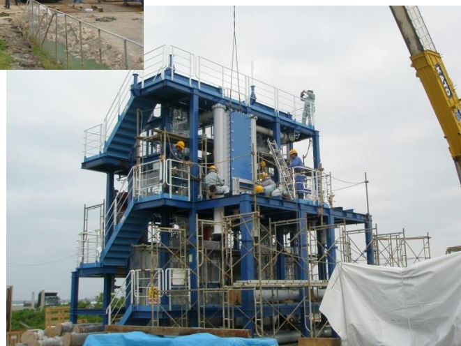
図 2 海洋温度差発電装置の建設の様子
